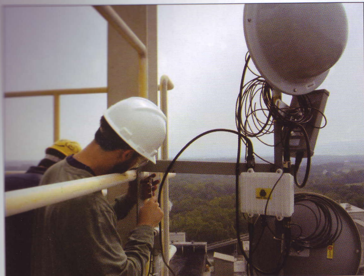
图 2. 安装区域天线和无线路由器。
