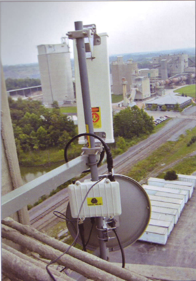
图 4. 2.4 GHz 和 5.8 GHz 回程线路天线。
